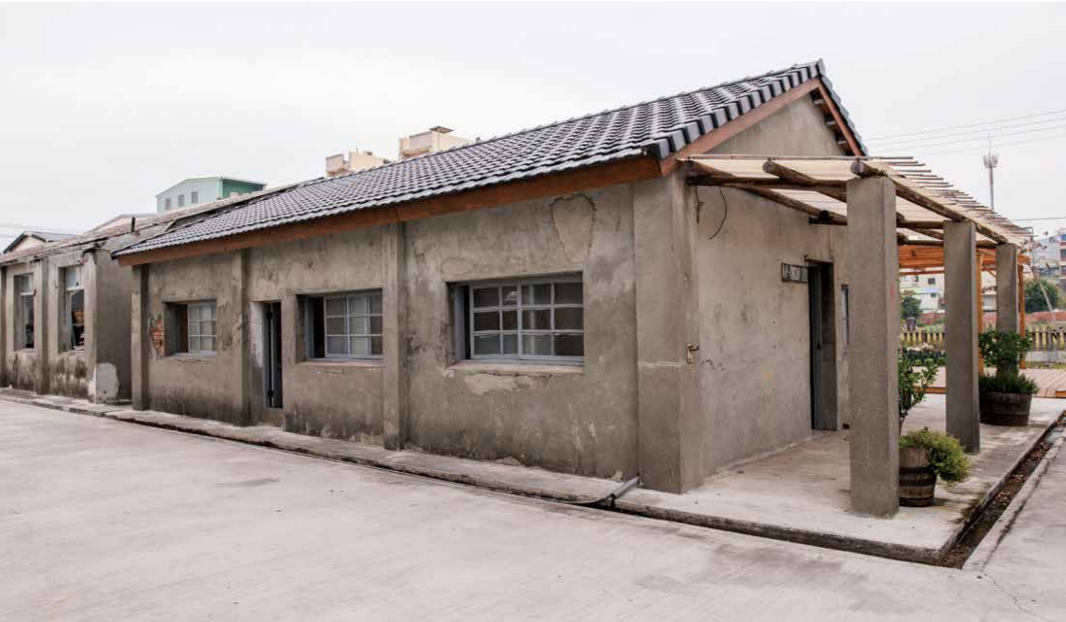
旗津灶咖外觀（高美館資料照片）
