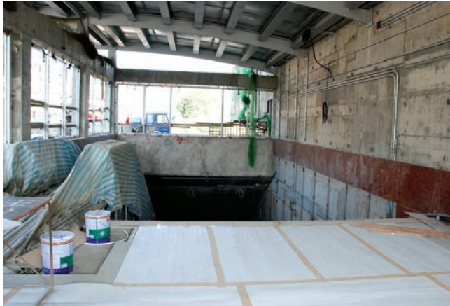
○11鳳山西站車站站體的初胚結構
