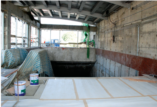
○11鳳山西車站站體的初胚結構
