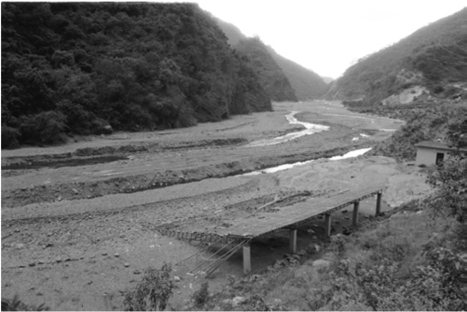
1996 年，賀伯颱風造成嚴重土石流，新好茶南隘寮溪天然游泳池砂土暴漲超過二層樓高，水道完全改變。(1996 年 5 月攝於新好茶)
